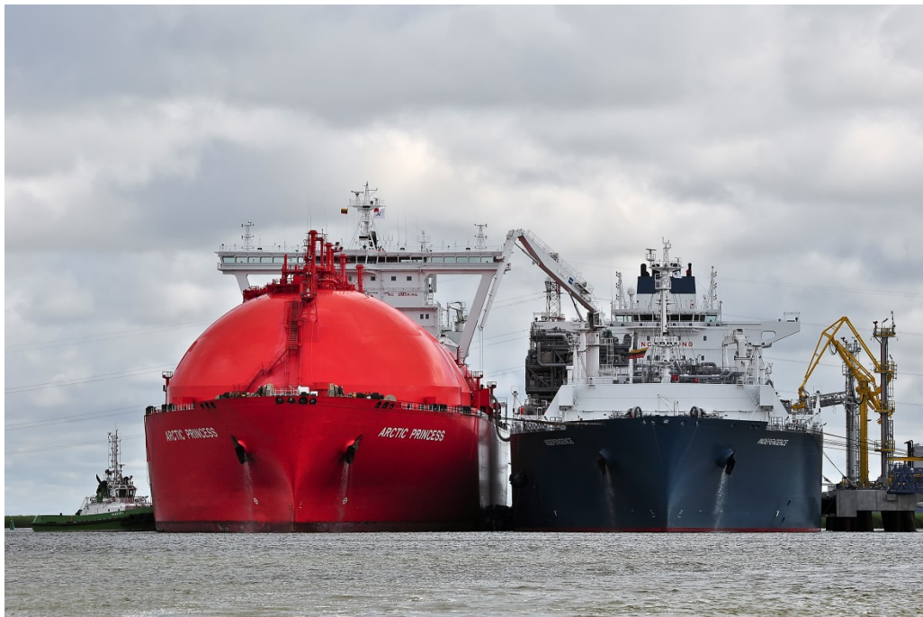
LNG Transfer with cryogenic flexible hoses
